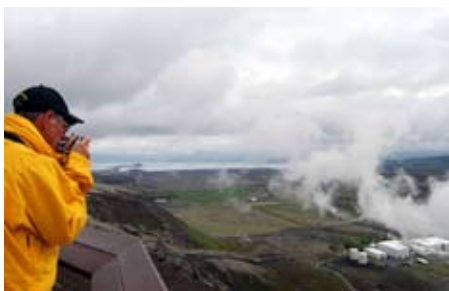
Ett av Islands värmekraftverk väckte stort intresse.
